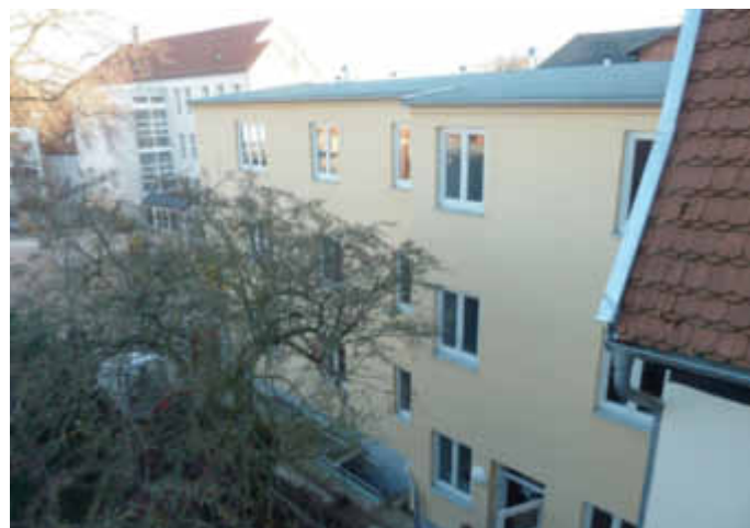
Blick auf den hinteren Gebäudeteil von 1933 nach der Sanierung
