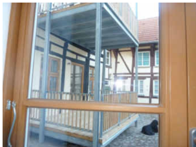
Anbau von Balkonen an die hofseitige Fachwerkfassade des Vorderhauses
