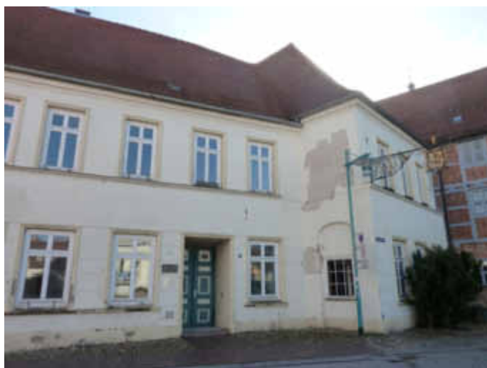
Straßenansicht kurz vor Sanierungsbeginn
