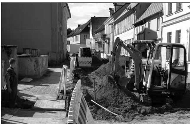
Arbeiten an den Hausanschlüssen im 2. Bauabschnitt Domstraße
