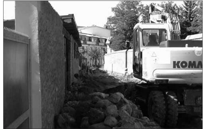
Auskofferungsarbeiten Friedrich-Schult-Weg entlang der Mauer
