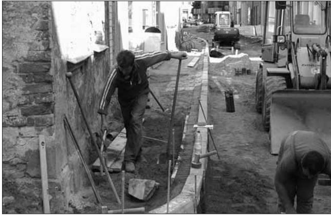
Setzen der Borde in der Domstraße
